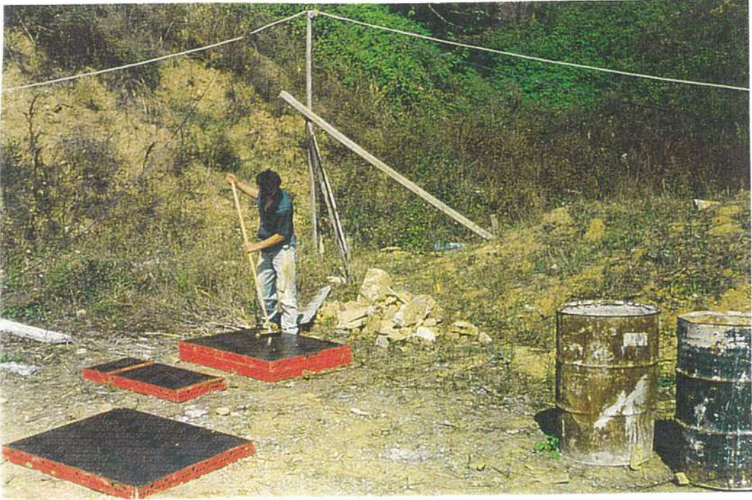
Resim 3.8 Kalıpların Temizlenip Yağlanması
