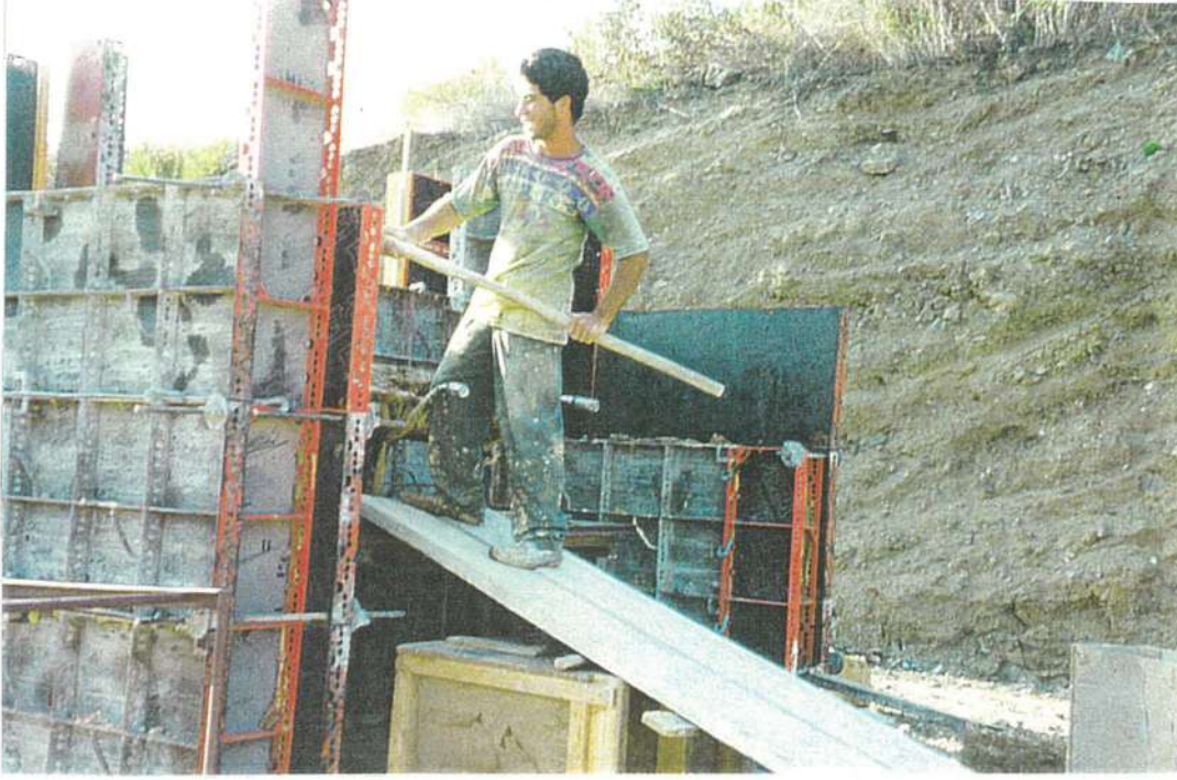
Resim 3.9 Karışımın El Arabasından Kalıplara Boşaltılması
