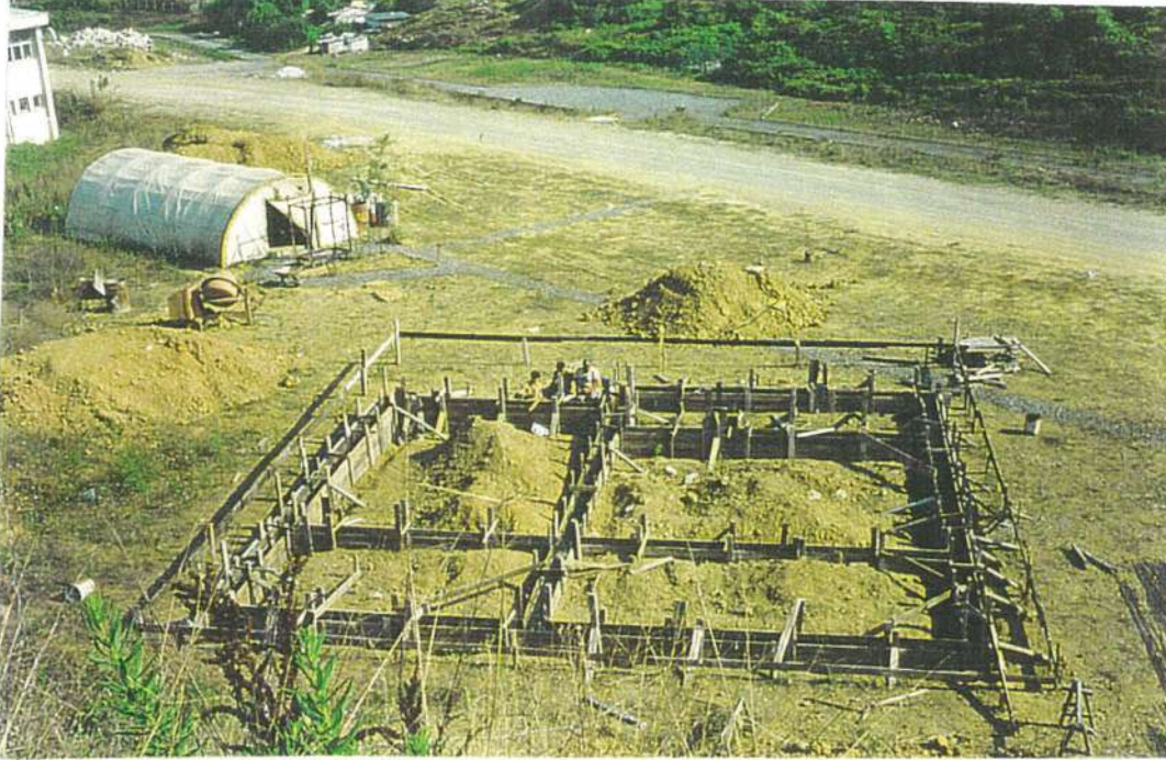
Resim 3.28 Temel Hatılı İçin Kurulan İp İskelesi Ve Yapılan Kazı
