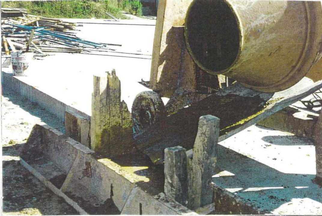
Resim 3.18 Likit Kıvamlı Harcın Kalıba Boşaltılması
