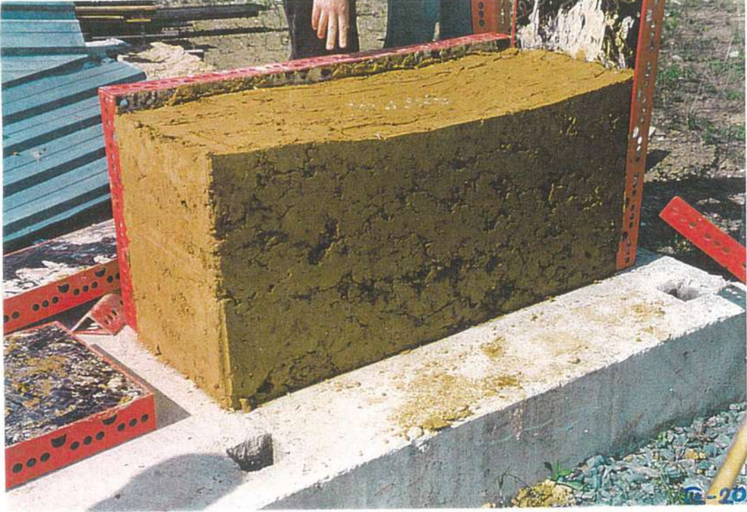
Resim 3.1. Şantiyede Dökülen Numune Blok
