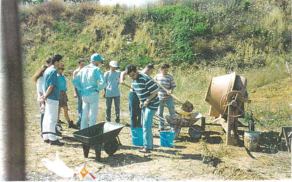
Resim 3.2 Toprağın Küreklerle Betoniyere Yerleştirilmesi
