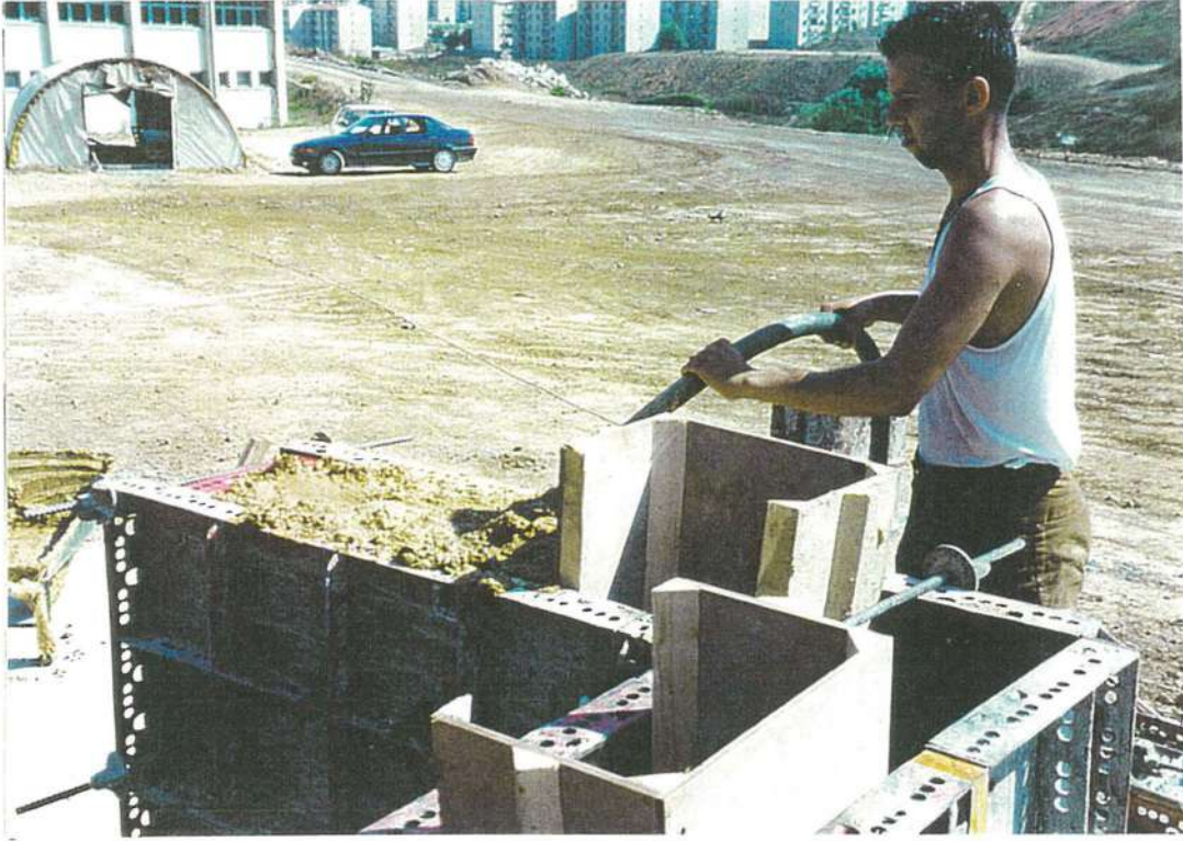
Resim 3.13 Akıcı Plastik Kıvamlı Karışımlarda Şişe Vibratör Kullanılması
