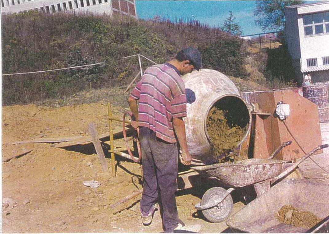
Resim 3.4 Betoniyerin Boşaltılması
