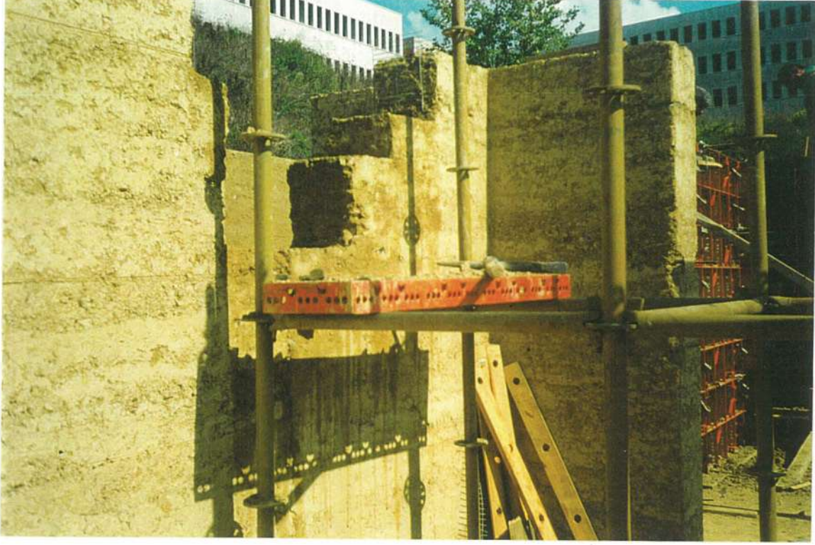
Resim 3.24 Hatalı İş Derzinin Onarılması
