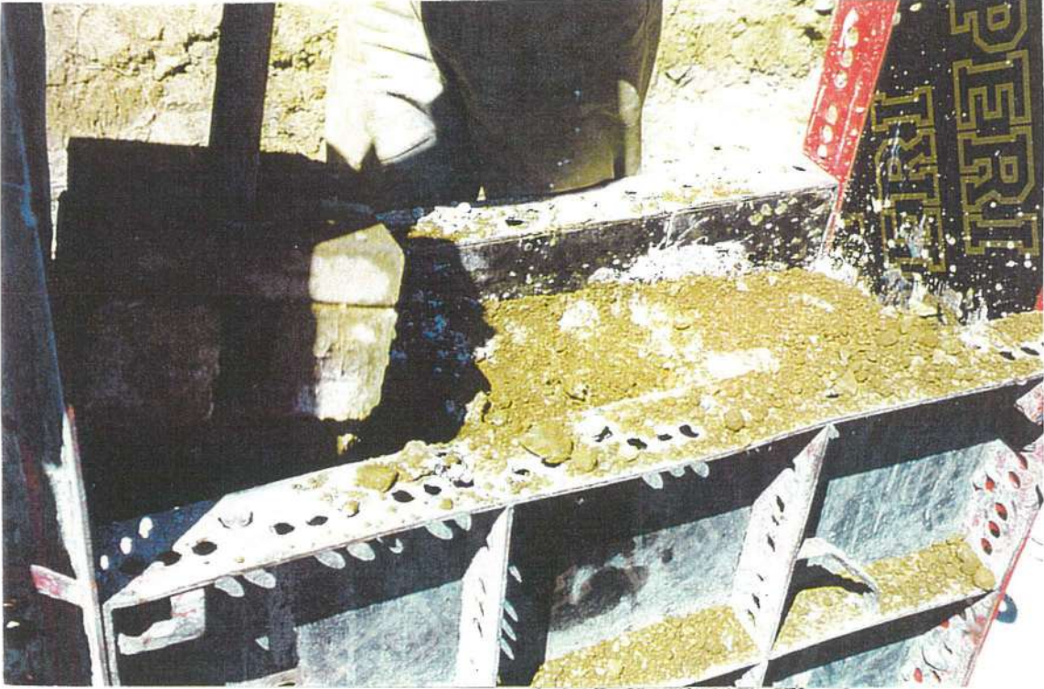
Resim 3.16 Kuru Kıvamdaki Karışımın Sıkıştırılmasının Zorluğu
