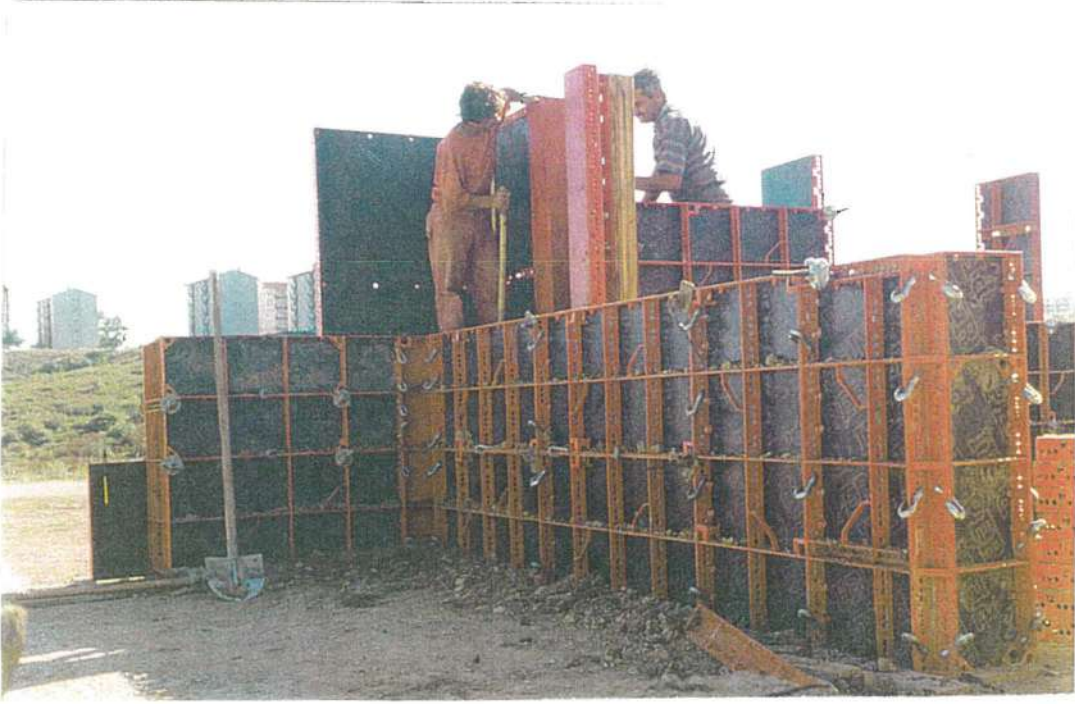
Resim 3.7 Kerpiç Duvar Dökümü İçin Kullanılan PERI Hand-set Sistem Kalıpları
