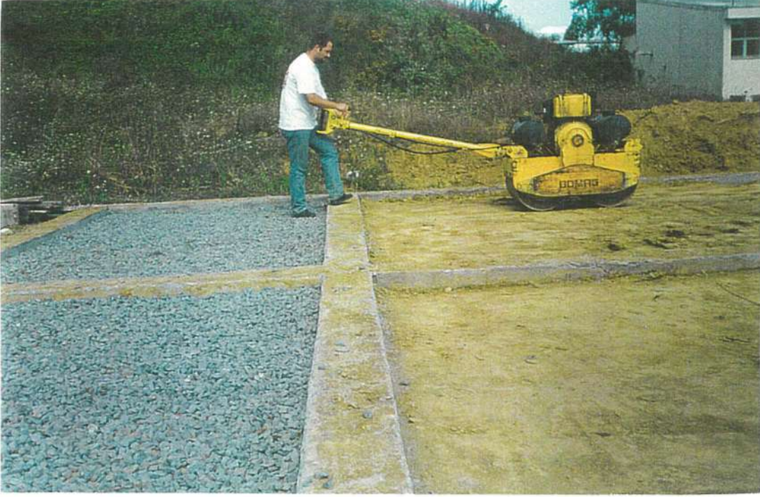
Resim 3.29 Zeminin Sıkıştırılması
