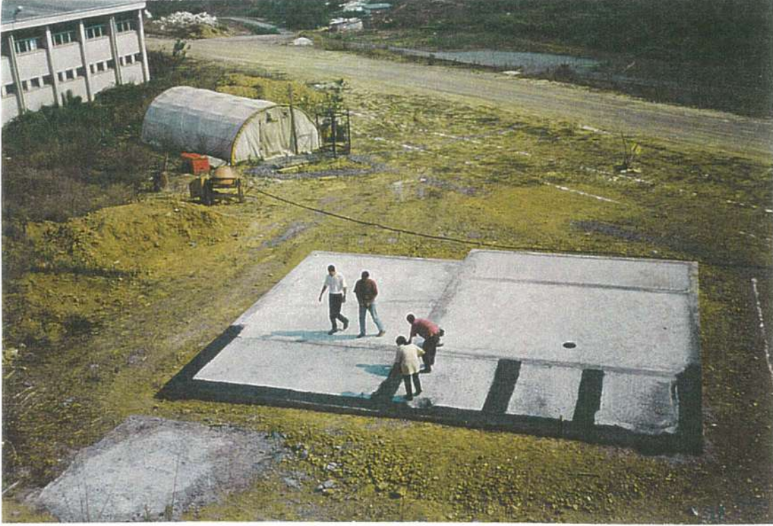
Resim 3.31 Duvar Alt Yüzeylerine Su Yalıtımı Sürülmesi
