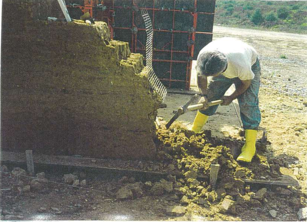
Resim 3.32 Duvar İçine Yerleştirilen Deprem Hatılı
