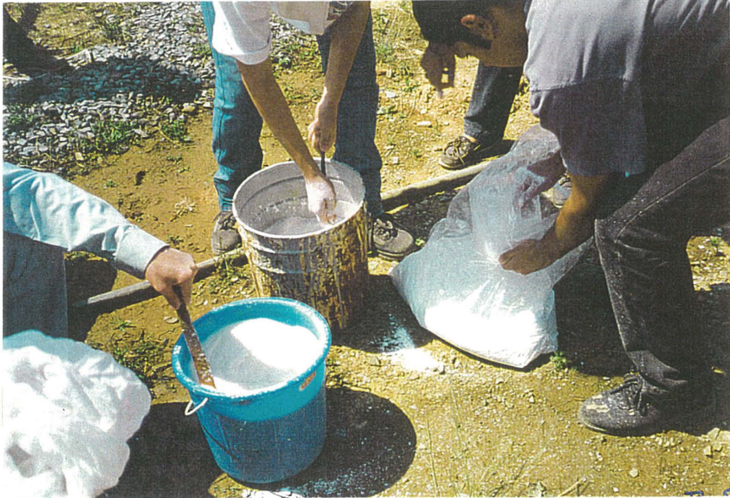
Resim 3.3 Ölçeklendirilmiş Kovalarda Alçı + Kireçli Su Karışımının Hazırlanması
