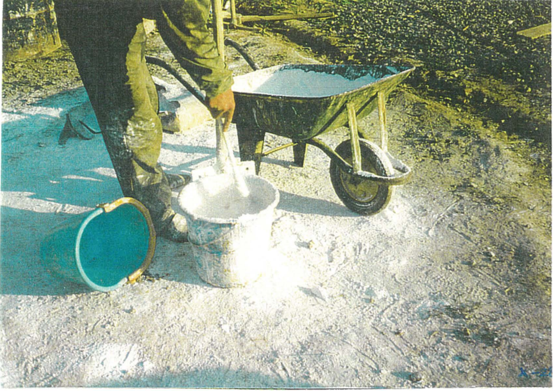
Resim 3.5 Alçı +Kireç+Su Oranları El Arabası ve Kürek Birimlerine İndirgenmesi
