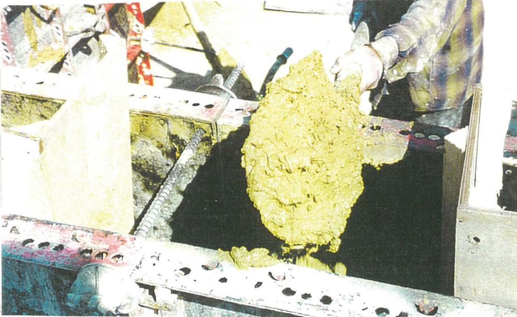
Resim 3.21 Kohesiv Karışımın İşlenebilme Güçlüğü
