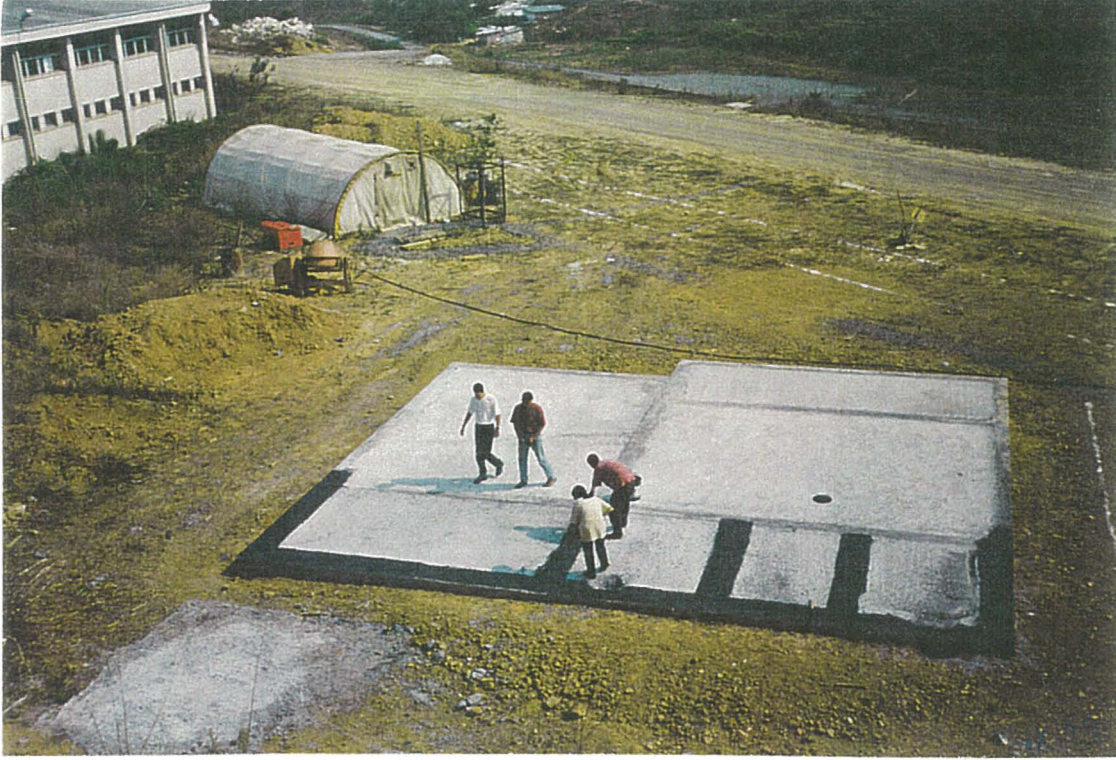
Resim 3.31 Duvar Alt Yüzeylerine Su Yalıtımı Sürülmesi
