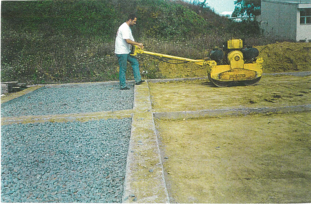
Resim 3.29 Zeminin Sıkıştırılması
