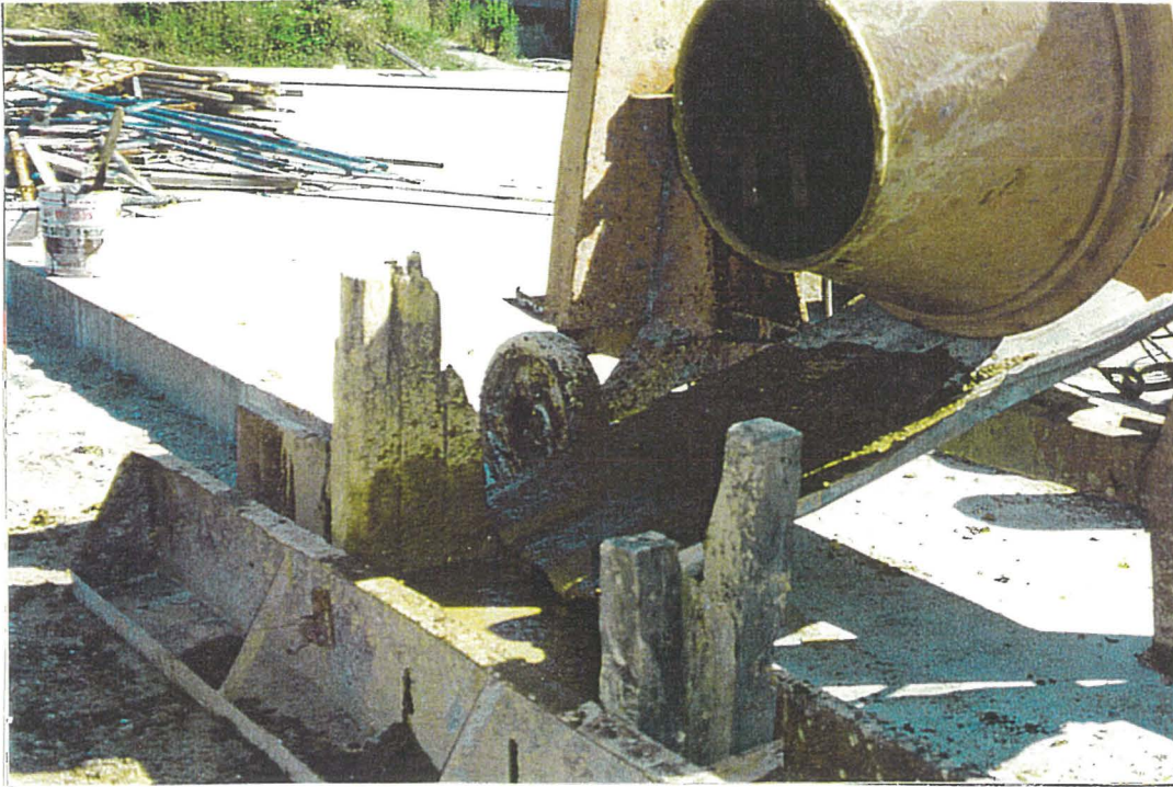
Resim 3.18 Likit Kıvamlı Harcın Kalıba Boşaltılması
