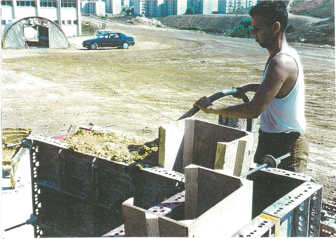
Resim 3.13 Akıcı Plastik Kıvamlı Karışımlarda Şişe Vibratör Kullanılması
