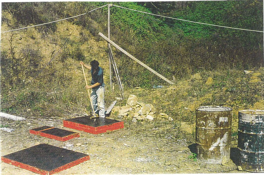
Resim 3.8 Kalıpların Temizlenip Yağlanması
