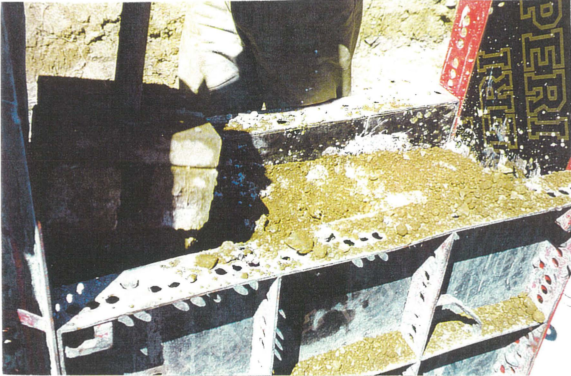
Resim 3.16 Kuru Kıvamdaki Karışımın Sıkıştırılmasının Zorluğu
