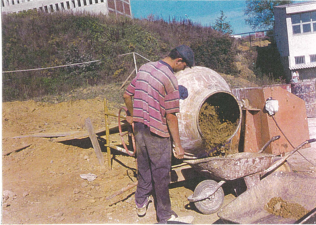
Resim 3.4 Betoniyerin Boşaltılması
