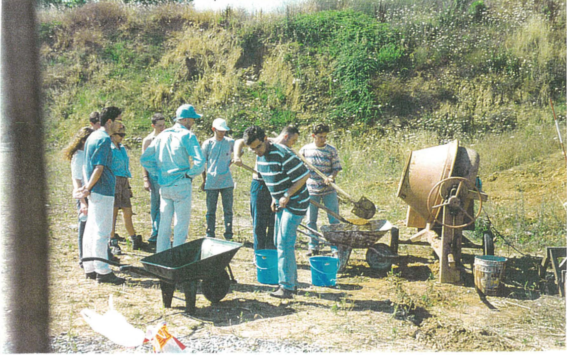
Resim 3.2 Toprağın Küreklerle Betoniyere Yerleştirilmesi
