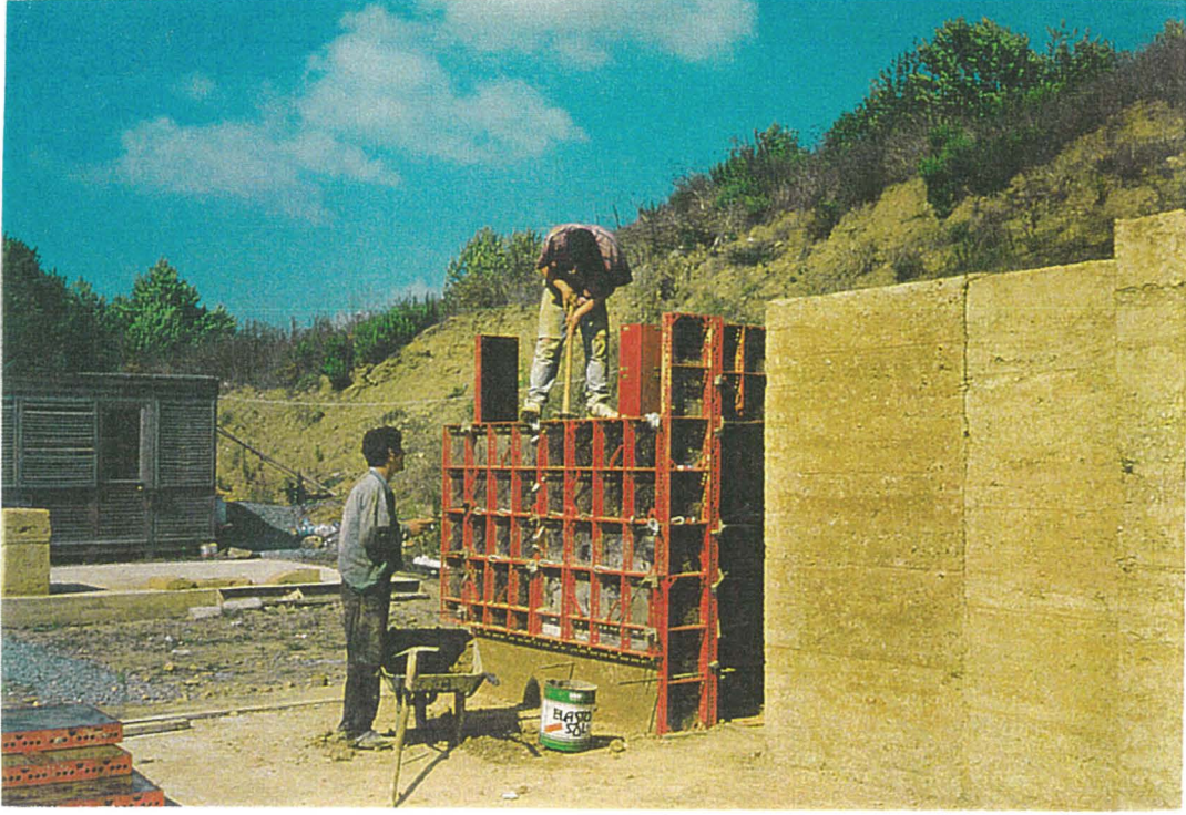
Resim 3.10 Kalıba Dökülen Harcın Balyozla Sıkıştırılması
