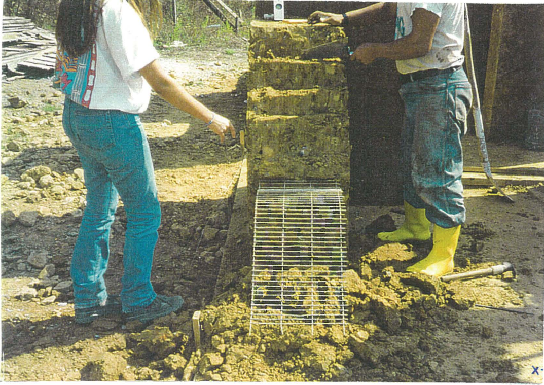
Resim 3.25 Basamakların Min.50 cm Olması Halindeki Çalışma Güçlüğü
