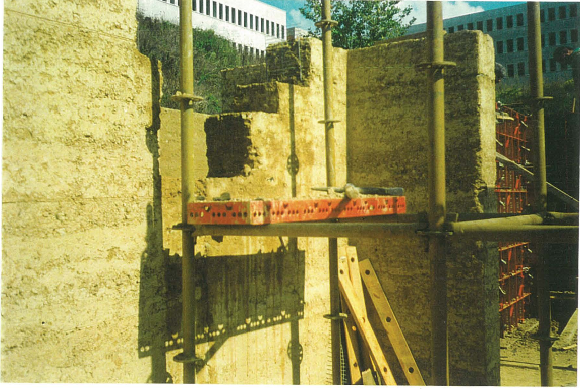
Resim 3.24 Hatalı İş Derzinin Onarılması
