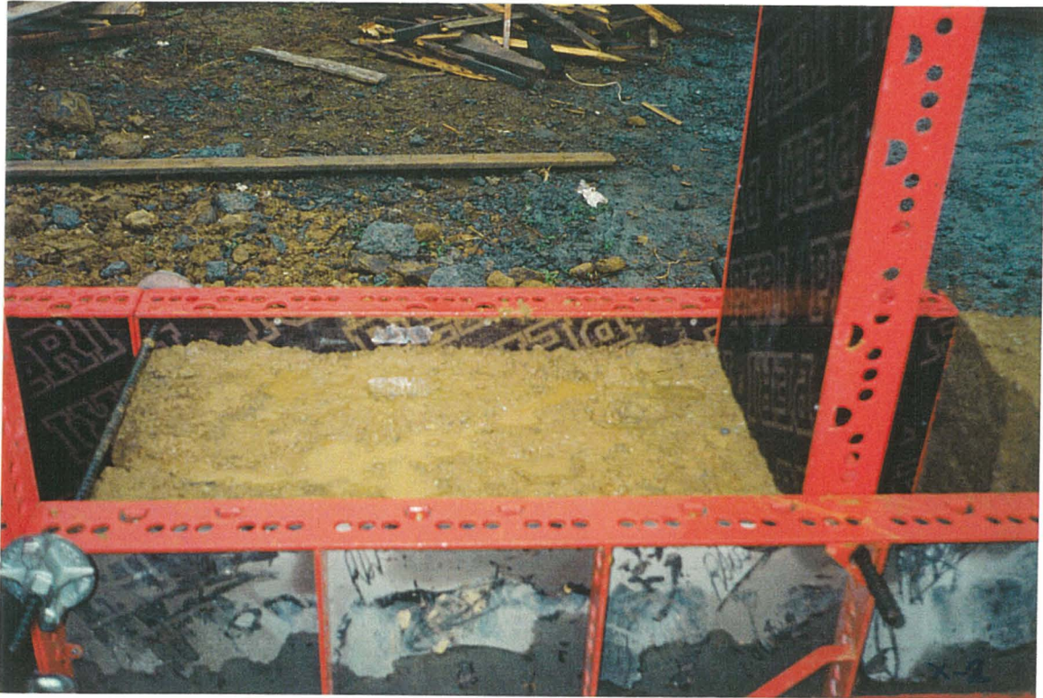
Resim 3.22 Kesintili Dökülen Duvar Örneği
