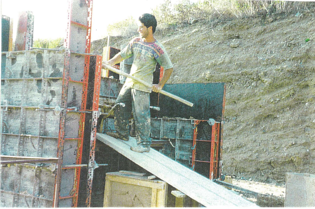
Resim 3.9 Karışımın El Arabasından Kalıplara Boşaltılması
