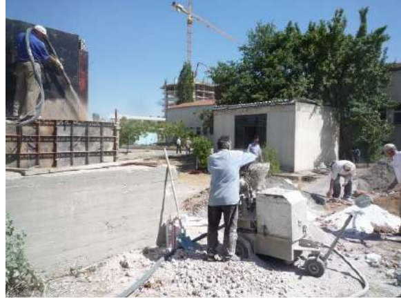
(R.53) Shotcrete ile dolgu
