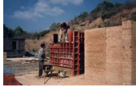
(R.32) Beton Kalıbı
