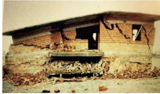
(R.12) Taş+ tuğla tarihi yığma yapı (R.13) Depremde köşegen kırılan önlemsiz yığma yapı
