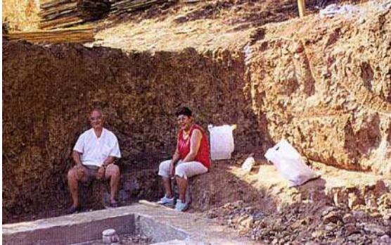
(R.33) Altınoluk Hafriyat Toprağı İnşaat
