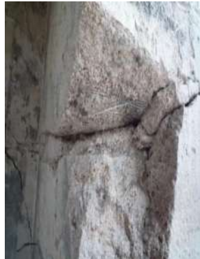
(R.25) İnşaat:shot makinası (R.26) Duvarda yatay kaydırma, (R.27) Köşegen çatlak ilerlemez
