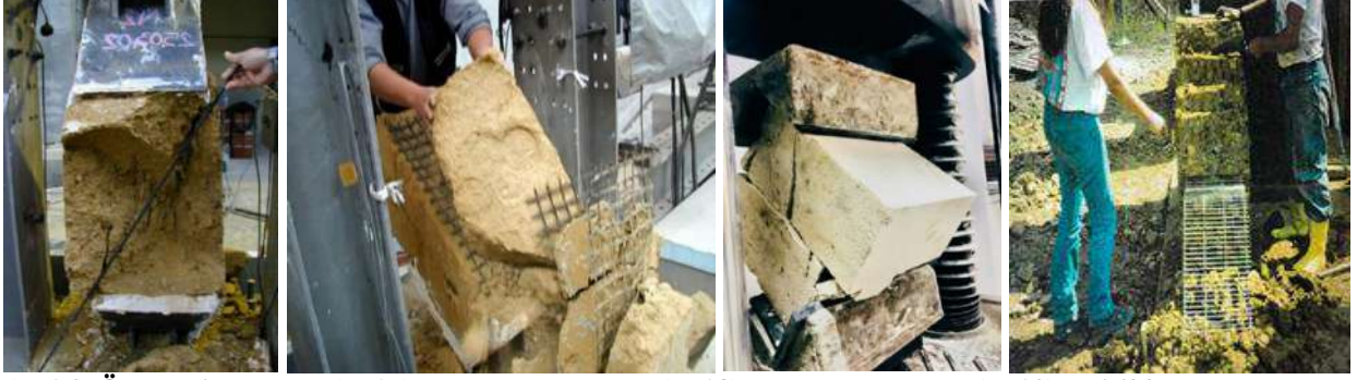
(R.16) Önlemsiz duvar (R.17) Yatay kaydırma (R.18) Köşegen çatlak (R.19) Prj622 Deprem tekno
