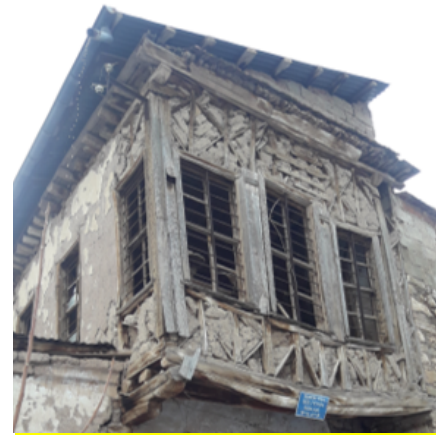
Fig.3.3. A şahnişin built with the technique of hımış
