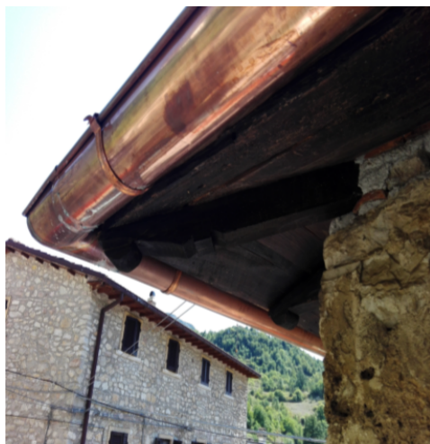
Figure 16. La canalizzazione del tetto in rame
