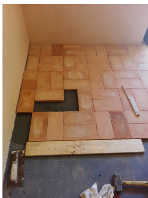
Figure 13. Lavorazione del pavimento in cotto
