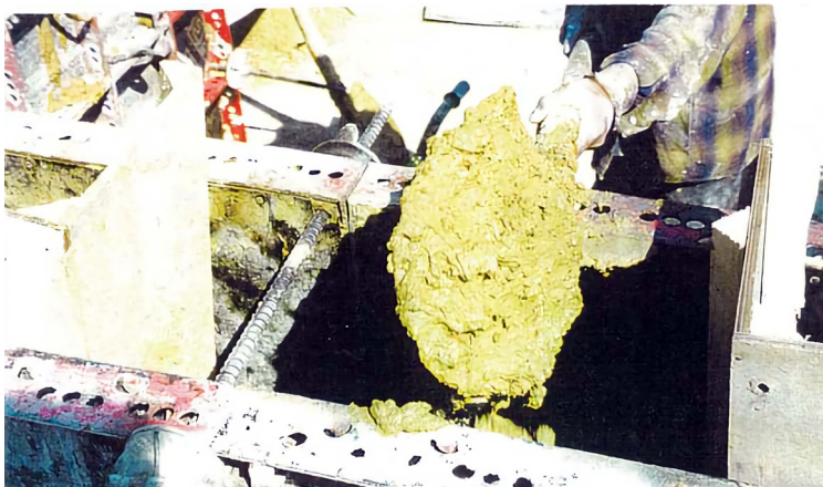
Resim 3.21. Kohesiv Karışımın İşlenebilme Güçlüğü Picture 3.21. Workability Difficulty of Cohesive Mixture
