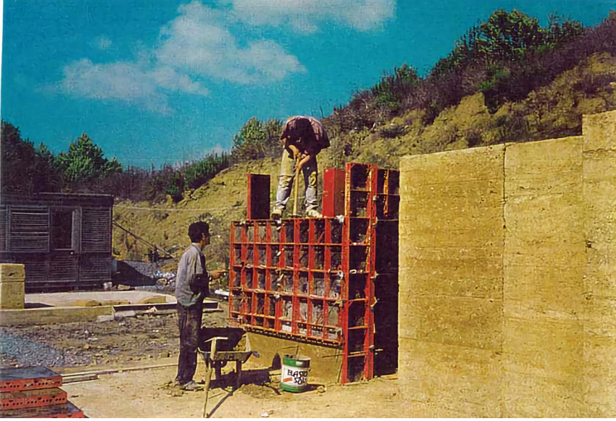
Resim 3.10. Kalıba Dökülen Harcın Balyozla Sıkıştırılması
