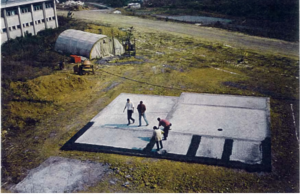
Resim 3.31. Duvar Alt Yüzeylerine Su Yalıtımı Sürülmesi Picture 3.31. Water Insulation Applied to Lower Surfaces of Wall
