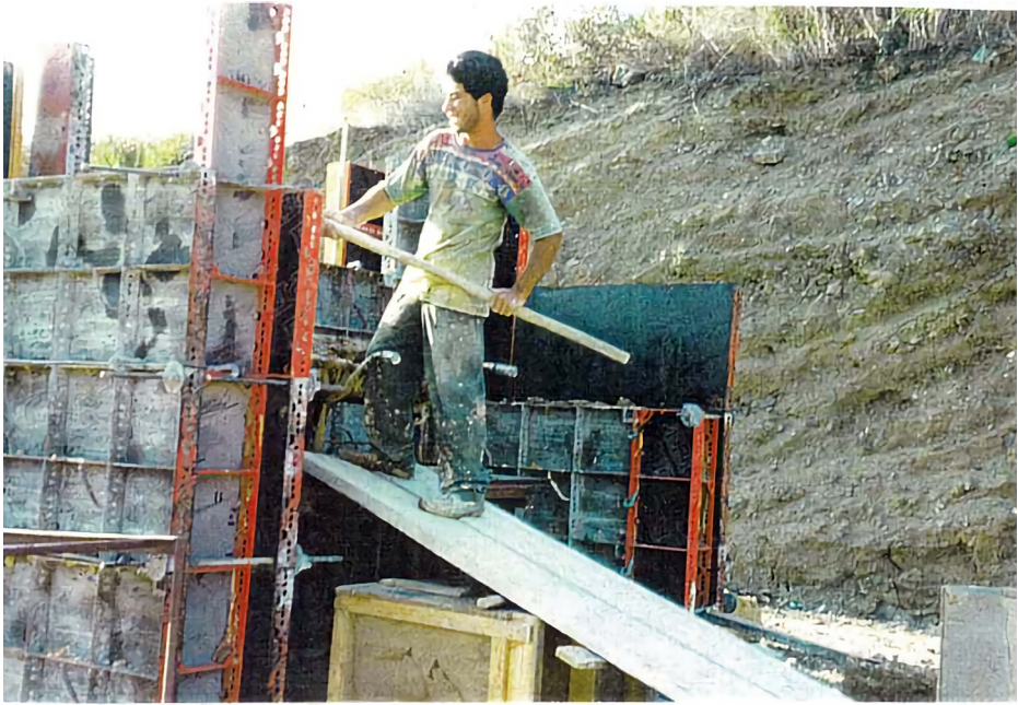
Resim 3.9. Karışımın El Arabasından Kalıplara Boşaltılması Picture 3.9. Discharge of the Mixture from Handcarts into Moulds
