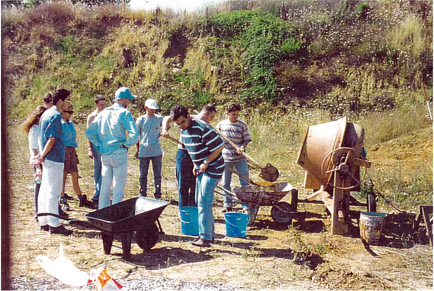
Resim 3.2. Toprađın Kreklerle Betoniyere Yerleřtirilmesi Picture 3.2. Shoveling Soil into Concrete Mixer
