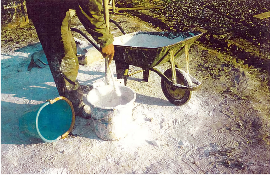
Resim 3.5. Alçı +Kireç+Su Oranları El Arabası ve Kürek Birimlerine İndirgenmesi Picture 3.5. Turning Gypsum + Lime + Water Rates into Hand Chart and Shovel Units
