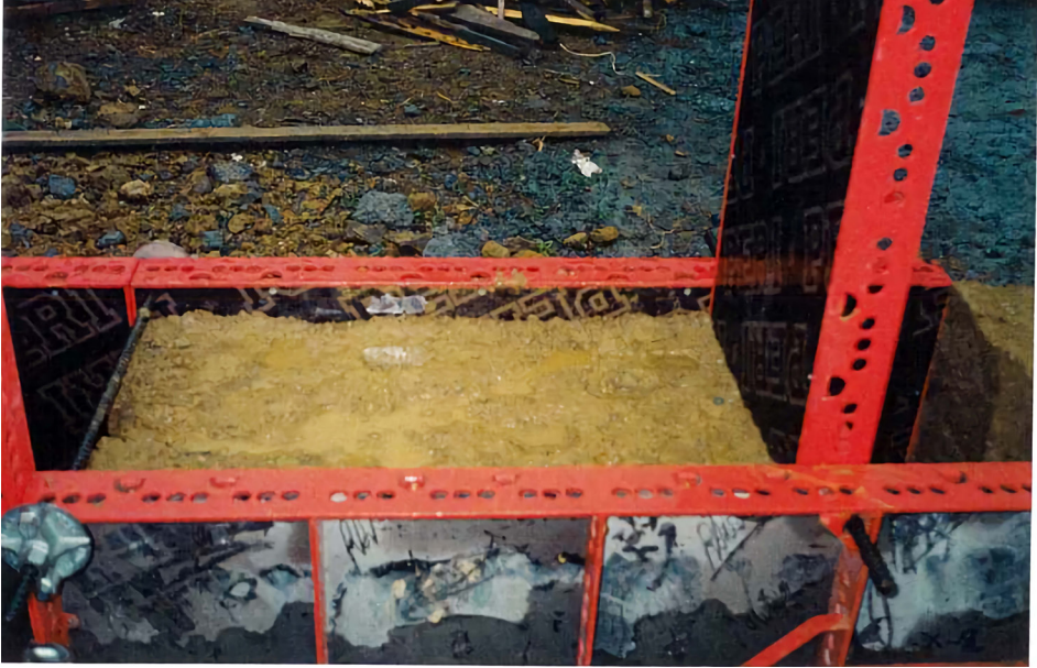
Resim 3.22. Kesintili Dökülen Duvar Örneği Picture 3.22. Example of Interruptedly Casted Wall
