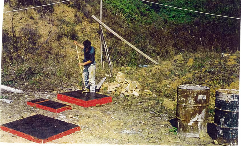
Resim 3.8. Kalıpların Temizlenip Yağlanması Picture 3.8. Cleaning and Lubrication of Moulds
