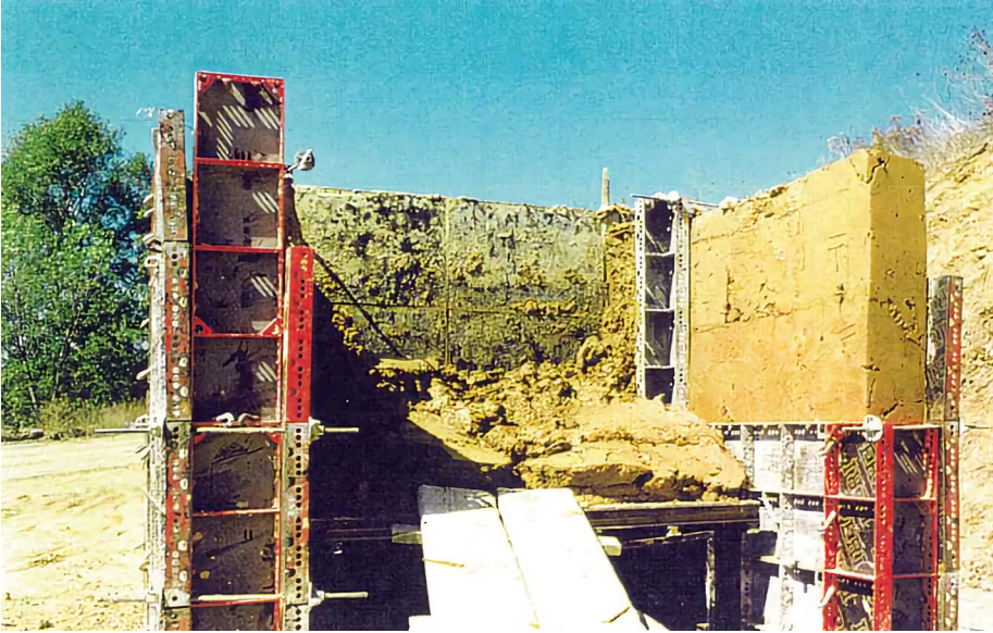
Resim 3.14. Alçının Priz Süresi Dışında Uygulanan Rö-vibrasyon Metodunun Sonucu
