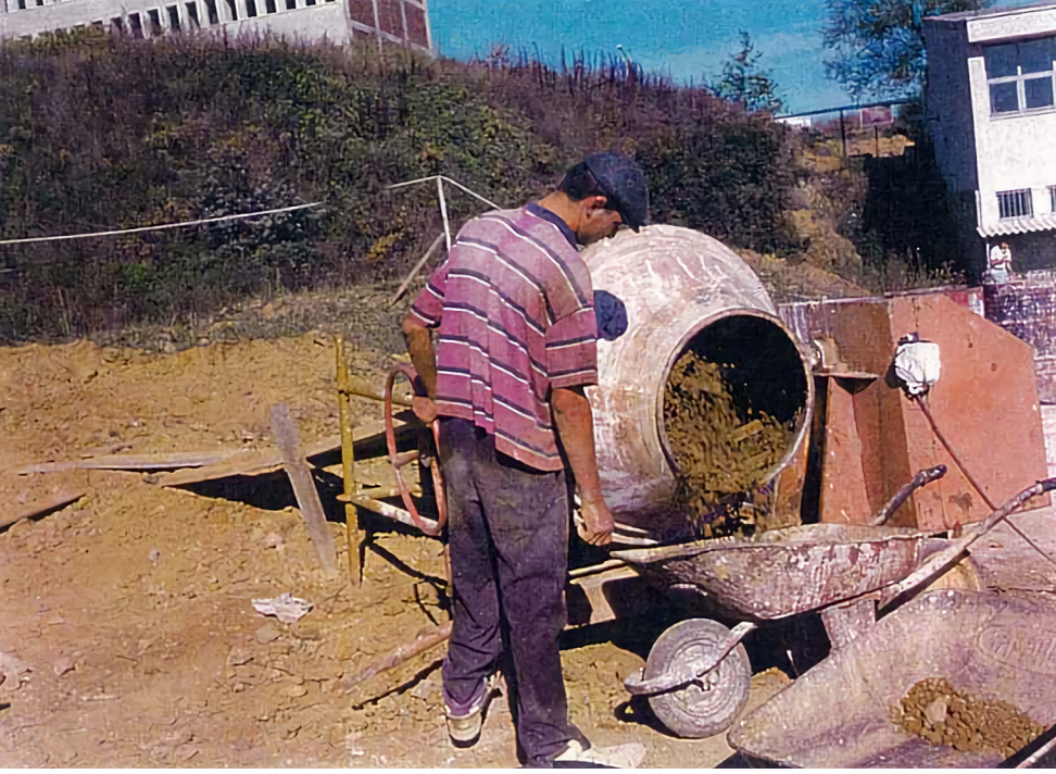
Resim 3.4. Betoniyerin Boşaltılması Picture 3.4. Discharge from Concrete Mixer
