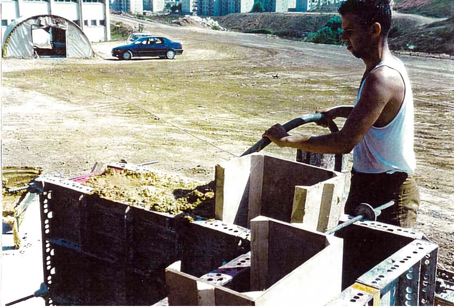
Resim 3.13. Akıcı Plastik Kıvamlı Karışımlarda Şişe Vibratör Kullanılması Picture 3.13. Use of Spud Vibrator in Mixtures at Fluid Plastic Consistency
