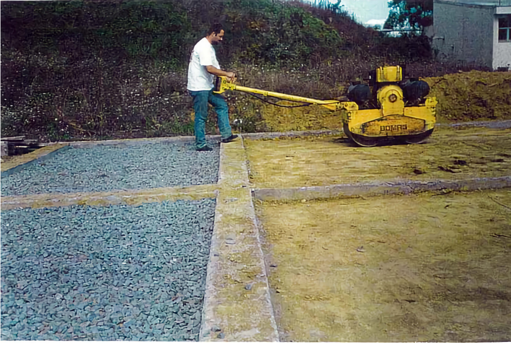
Resim 3.29. Zeminin Sıkıştırılması Picture 3.29. Compression of the Ground
