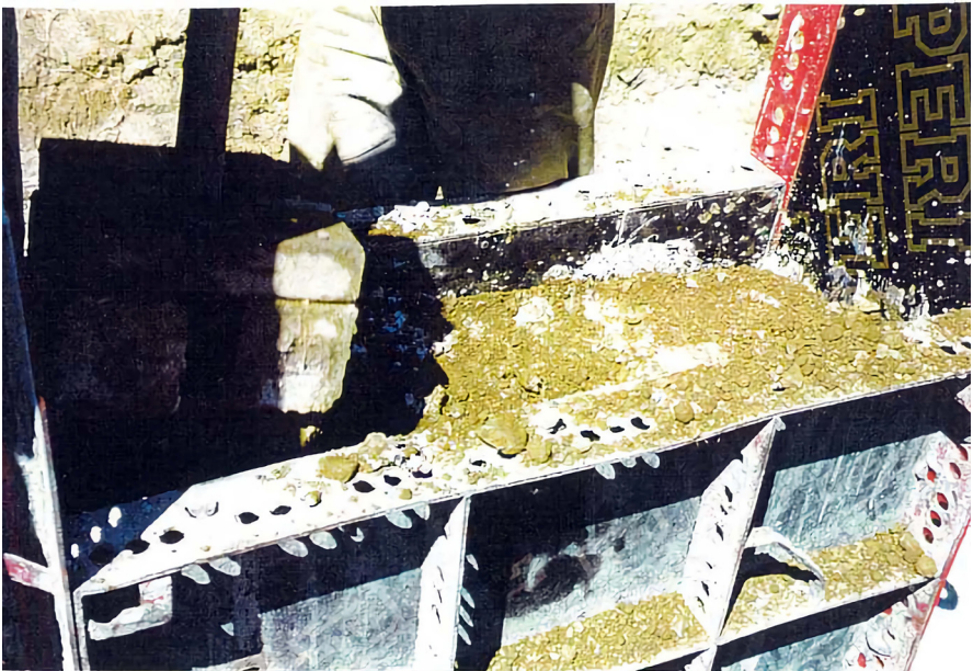
Resim 3.16. Kuru Kıvamdaki Karışımın Sıkıştırılmasının Zorluğu Picture 3.16. Difficulty in Compressing The Mixture at Dry Consistency
