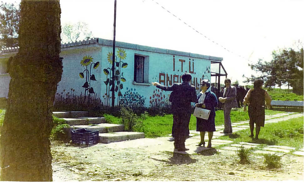
Resim 1.8.1.Deneme Yapısı ( Dış ) Picture 1.8.1st Case-Study Building (Exterior)
