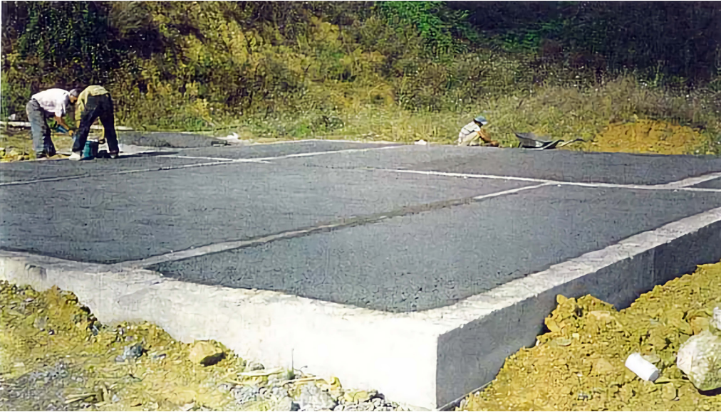
Resim 3.30. Zeminin Sıkıştırılması Picture 3.30. Compression of the Ground
